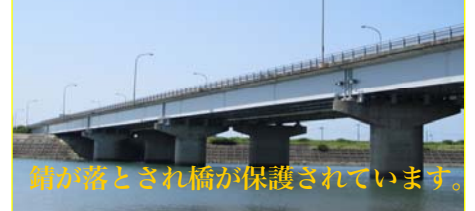
完成(平成24年度工事)
